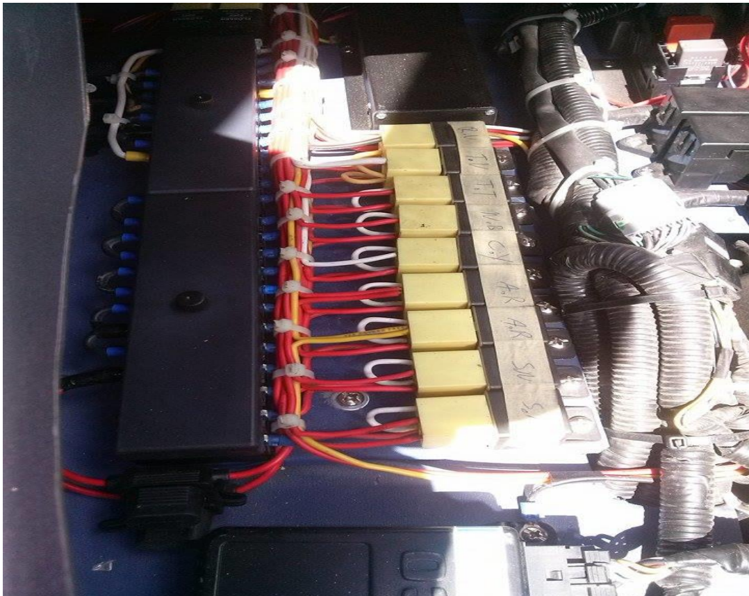
Figura 3.54. Instalación de sokets, conectores y fuselera
