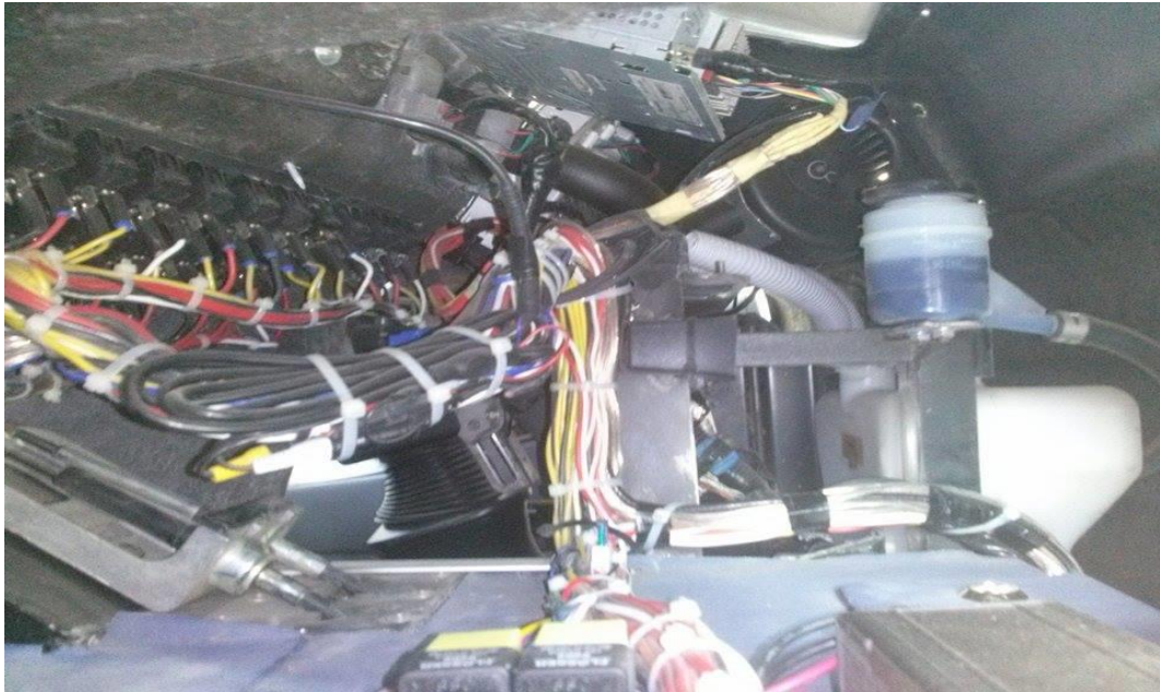
Figura 3.53. Instalación de terminales eléctricos.
