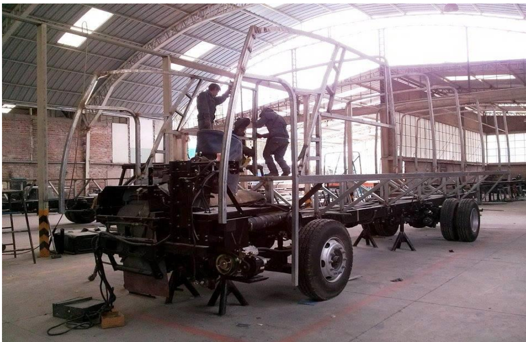
Figura 3.7. Construcción de estructuras laterales y techo
