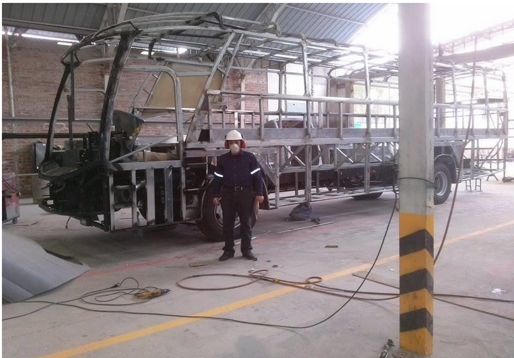
Figura 3.12. Estructura principal, de frente y de bodega
