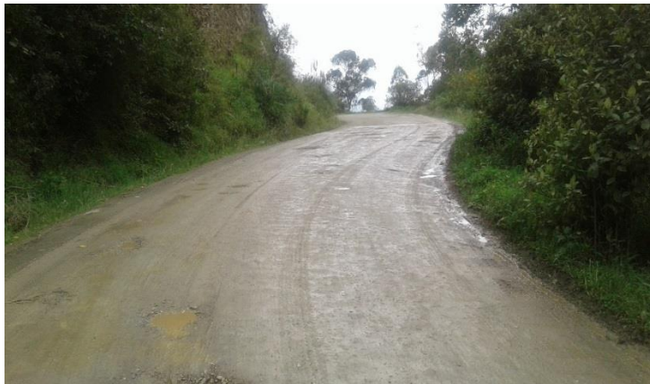
Ilustración 17. MAL ESTADO DE LA VÍA.
