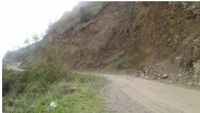
Ilustración 9. ESTADO DE LOS TALUDES.
