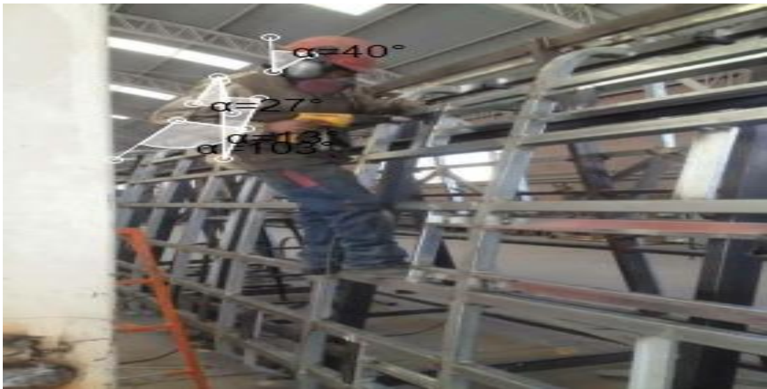
Figura 59 Trazo de ángulos en el Kinovea Operario taladro
