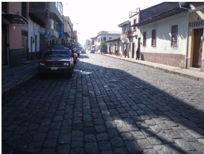
Ilustración 49: Calles del Centro Histórico antes de su intervención Fuente: Archivo GAD Riobamba
