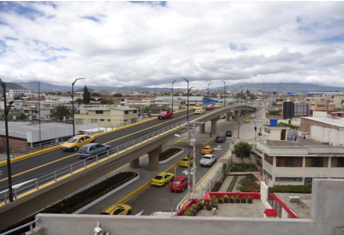
Ilustración 25: Paso Vehicular a Desnivel Fuente: Registro Propio
