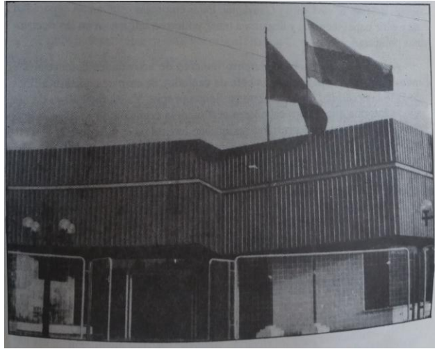
Ilustración 18: Edificio del Parque Industrial Fuente: Libro: La Antigua Riobamba, pág. 205
