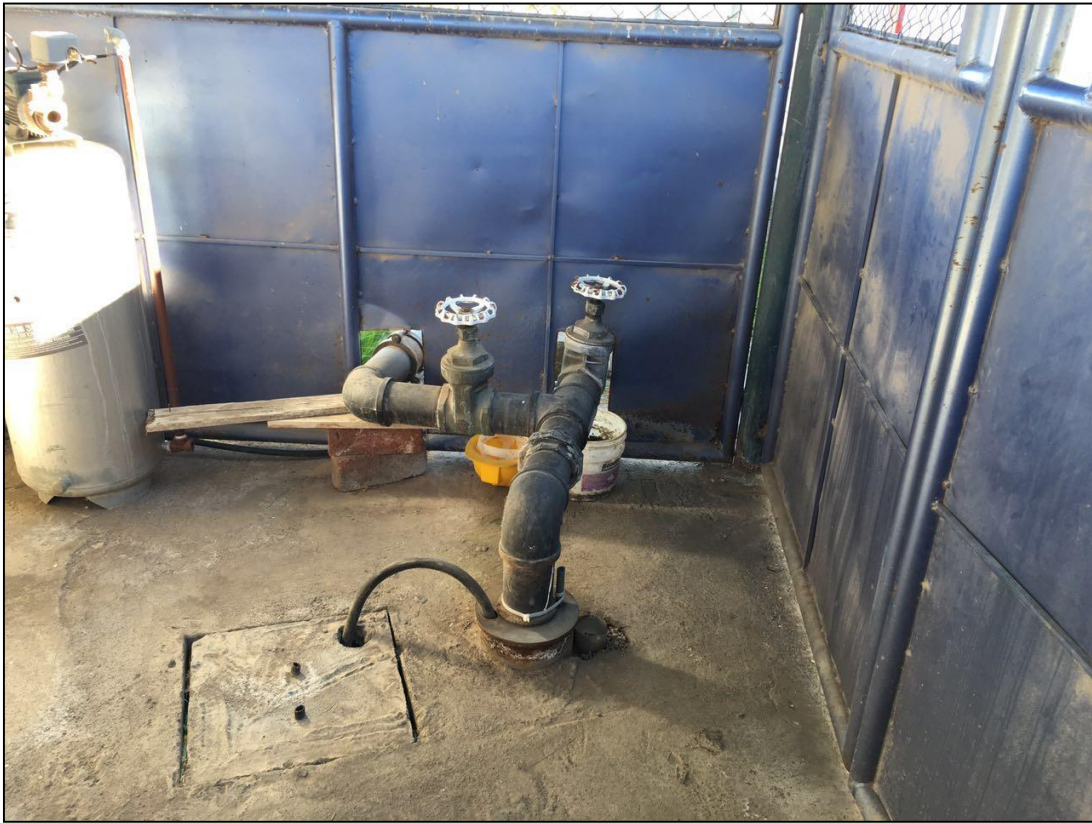
Anexo 3: Pozo UNACH
