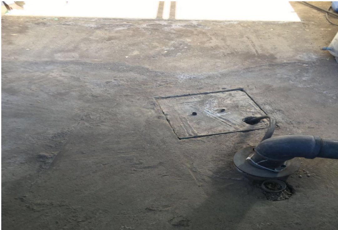
Anexo 4: Pozo UNACH
