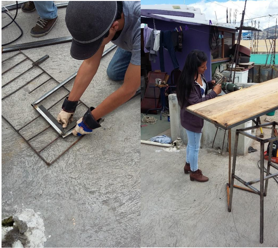
Figura 26: Construcción de la estructura. Fuente: Autor
