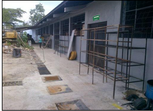
Vía de evacuación
