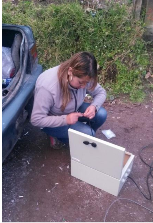
Figura 27. Instalación equipos backup Fuente: Los autores.
