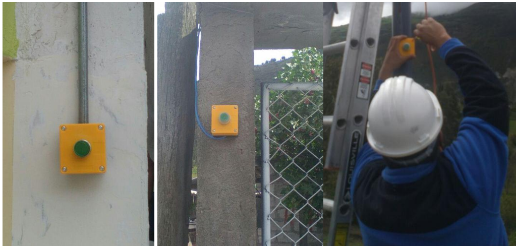
Figura 39. Instalación de pulsadores Fuente: Los autores.
