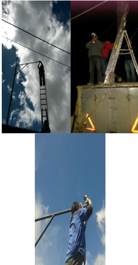
Figura 26. Instalación de cámaras Fuente: Los autores.
