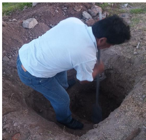
Excavación de calicata 0,50 x 0,50 x 0,50 m
