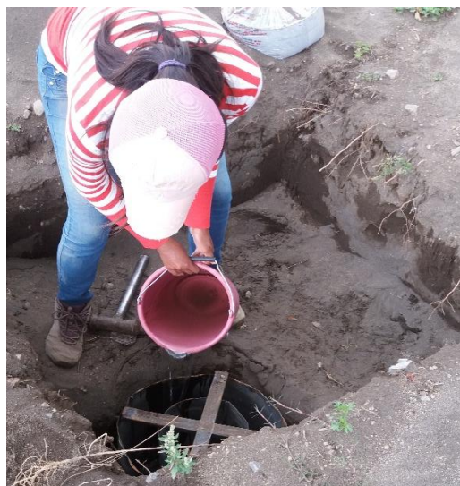
Llenado con agua del infiltrómetro
