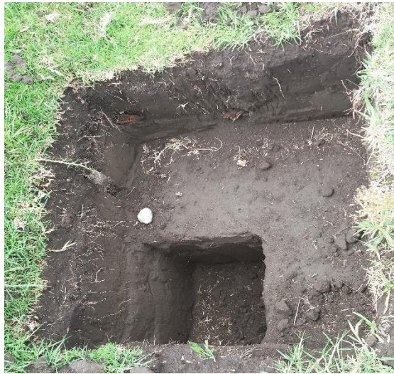
Calicata para ensayo
