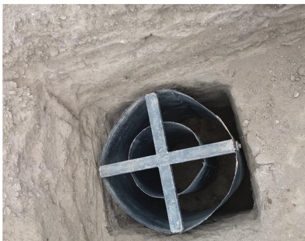
Ubicación del infiltrómetro en la calicata de ensayo
