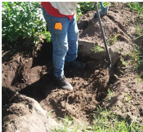
Excavación de calicata 1,00 x 1,00 x 0,50 m
