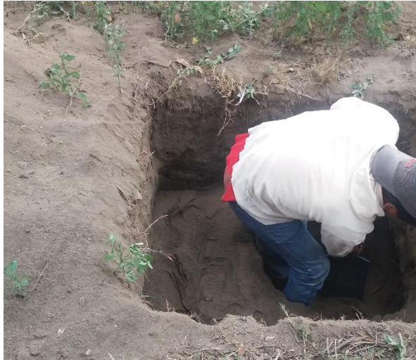
Excavación de calicata 0,50 x 0,50 x 0,50 m
