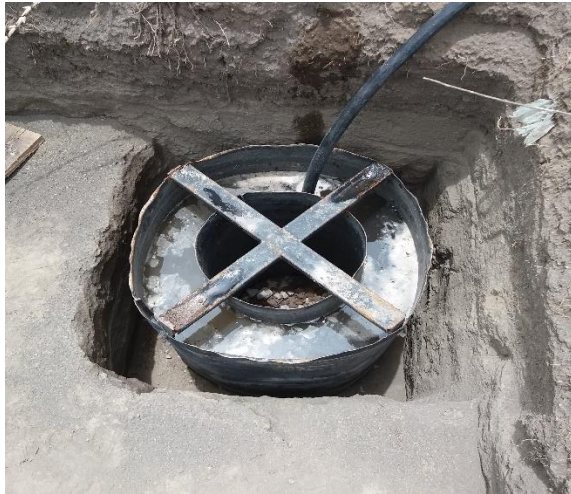
Llenado con agua del cilindro exterior
