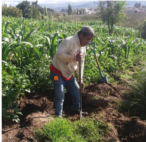
Excavación de calicata 1,00 x 1,00 x 0,50 m
