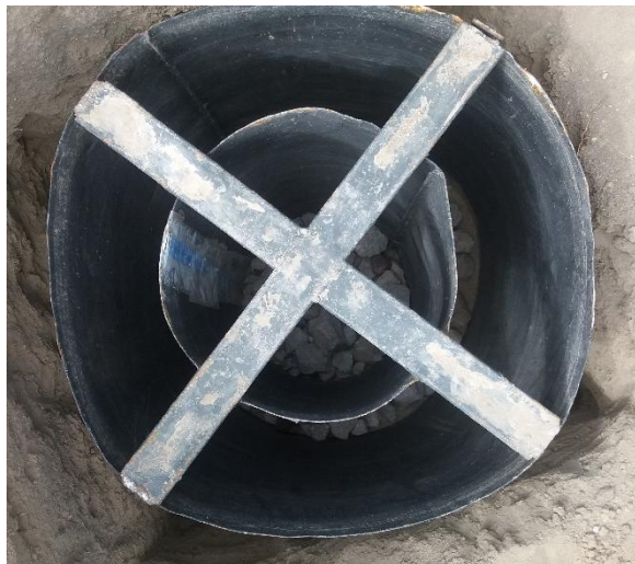
Grava en el fondo del infiltrómetro
