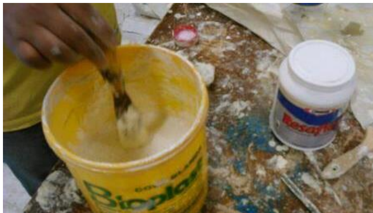
Ilustración 15: Mezcla de componentes del empaste para exteriores Fuente: Rocio guacho y Angélica Nauñay
