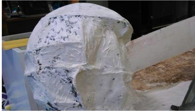
Ilustración 16: Cubrimiento del empaste a la estructura Fuente: Rocio guacho y Angélica Ñauñay
