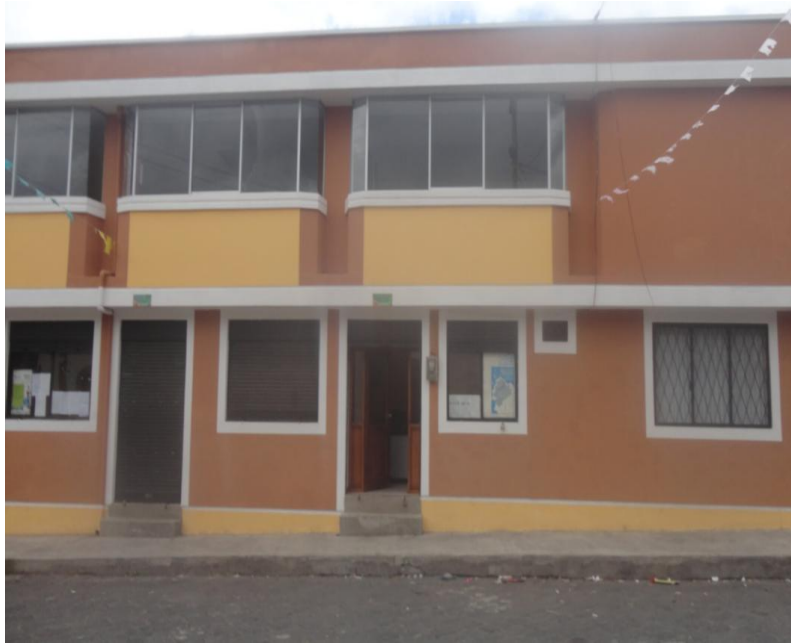
Infraestructura del Gobierno Autónomo Descentralizado de la Parroquia San Andrés
