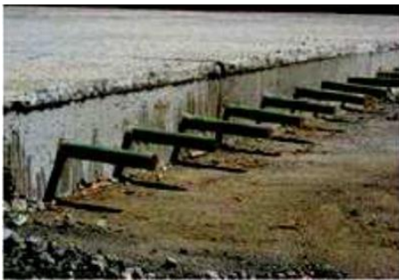
Ilustración 78.- Colocación de pasadores. En sentido transversal.
