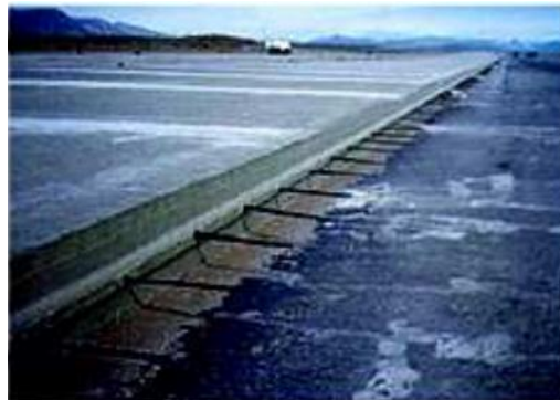
Ilustración 79.- Colocación Barras de unión. Sentido longitudinal.
