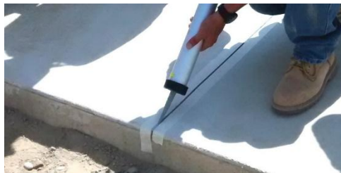
Ilustración 81.- Sellado de juntas.
