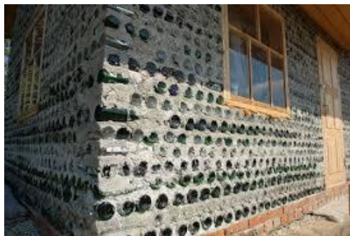
Ilustración 2.- Construcción de vivienda por medio de hormigón reciclado.
