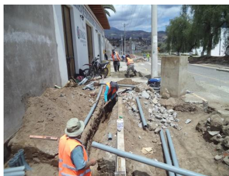
Ilustración 6. Excavación de zanja
