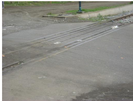
Ilustración 2. Plataforma de hormigón
