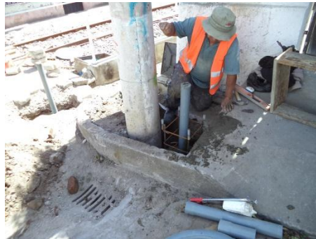
Ilustración 7. Basamento para semáforo
