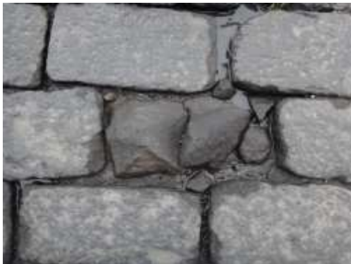
Ilustración 42. Fractura, severidad media Fuente: Autores del estudio
