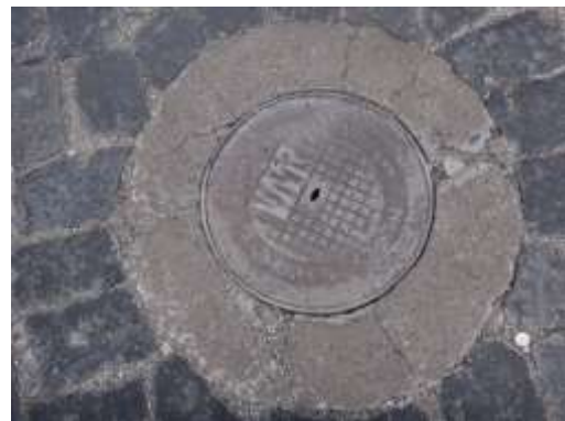
Ilustración 49. Confinamiento interno, severidad media Fuente: Autores del estudio
