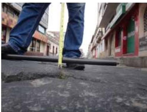
Ilustración 26. Abultamiento, severidad alta Fuente: Autores del estudio
