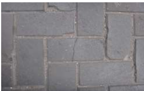
Ilustración 54. Fractura, severidad media Fuente: Autores del estudio
