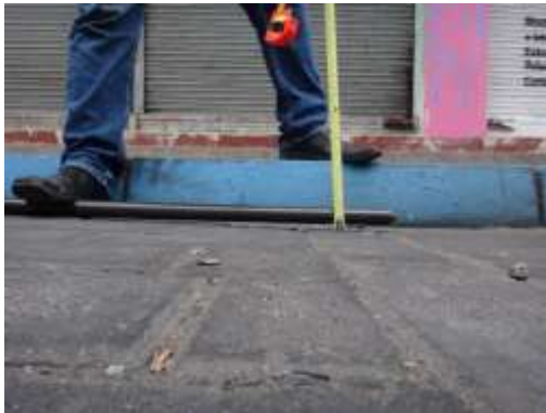
Ilustración 56. Abultamiento, severidad baja Fuente: Autores del estudio
