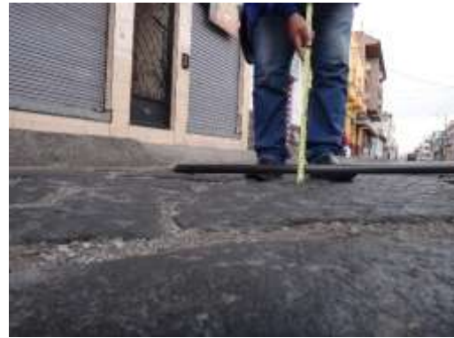
Ilustración 21. Depresión, severidad media Fuente: Autores del proyecto
