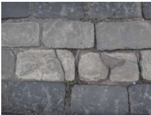
Ilustración 48. Fractura, severidad media Fuente: Autores del estudio
