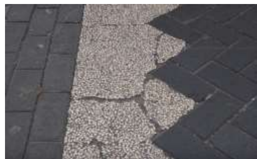
Ilustración 55. Confinamiento interno, severidad media Fuente: Autores del estudio
