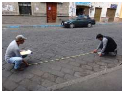
Ilustración 23. Perdida de arena, severidad alta Fuente: Autores del proyecto
