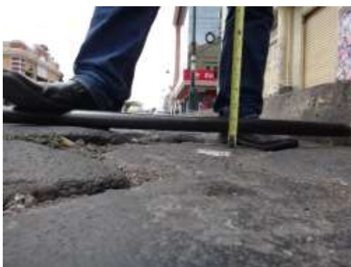
Ilustración 34. Abultamiento, severidad alta Fuente: Autores del estudio
