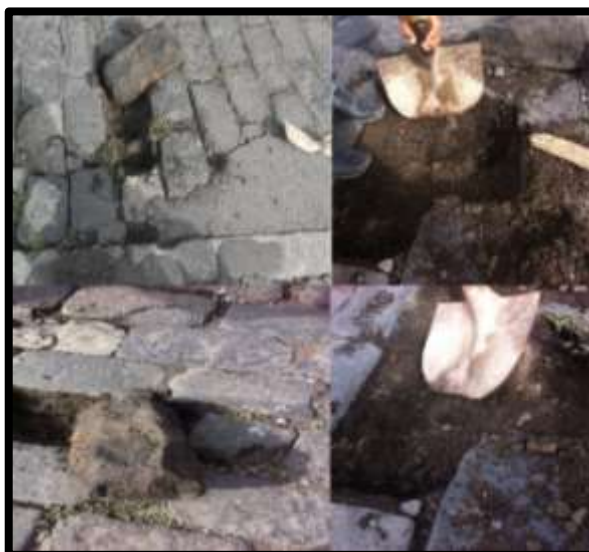
Ilustración 8. Inspección visual de la estructura del pavimento de la calle So de Agosto y Guayaquil
