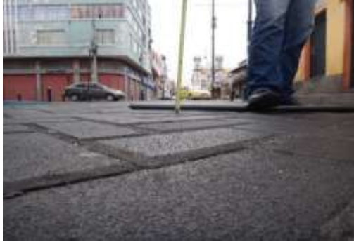
Ilustración 50. Abultamiento, severidad baja Fuente: Autores del estudio
