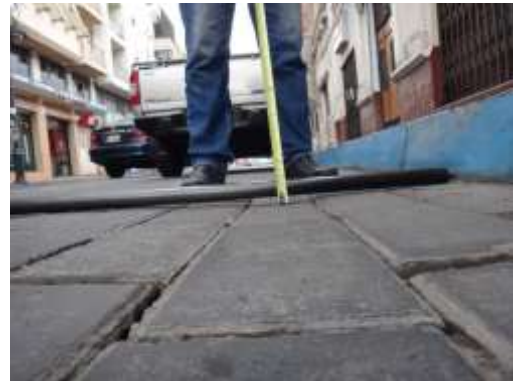
Ilustración 57. Depresión, severidad alta Fuente: Autores del estudio
