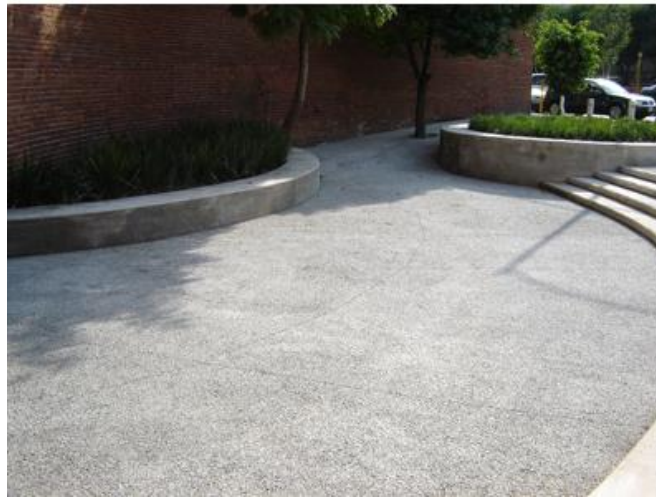
Ilustración 24.- Uso de Hormigón permeable en Camineras. Fuente: Pavimento Permeable – La Mejor Opción Contra las Inundaciones
