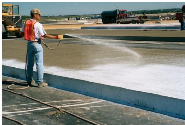
Ilustración 18. Agua para curado del Hormigón Fuente: Folleto redacción 360° en concreto. Protección y curado del concreto
