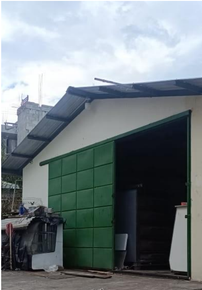
Anexo 3: Bodega es el almacenamiento de materia prima
