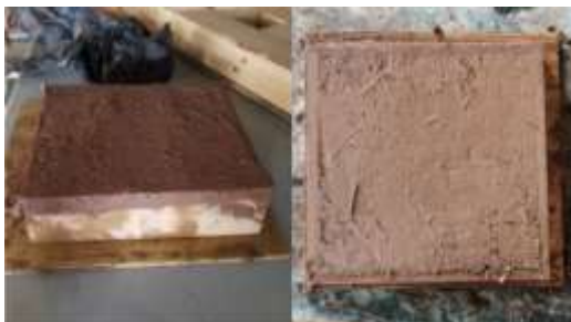
Imagen 82 Vertido de la mezcla de arcilla y paja en los moldes
