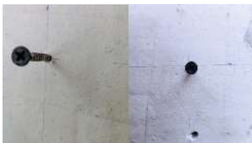
Imagen 142 Perforación de paneles Prefabricados
