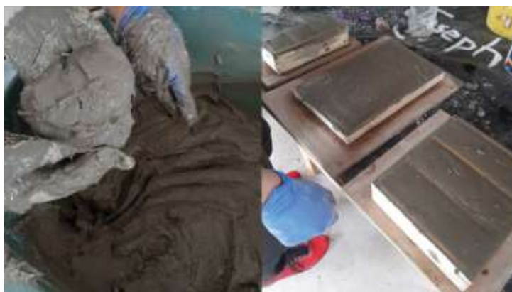
Imagen 85 Vertido de la mezcla de cemento y paja en los moldes Nota: Proceso de vertido de mezcla de cemento y fibras en los moldes
