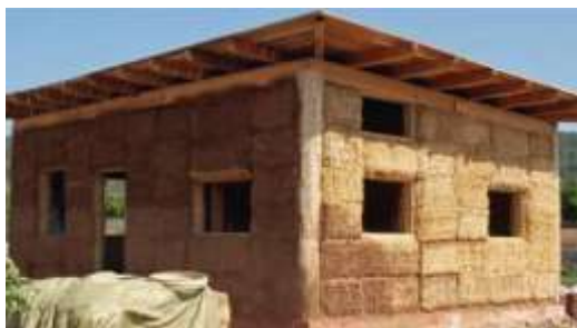
Imagen 54 Construcción balas de Paja
