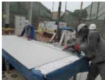
Imagen 43 Tableros de fibrocemento
