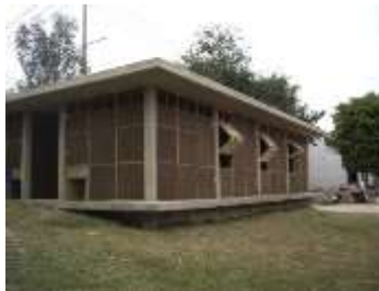
Imagen 36 Construcción con muros de Bahareque
