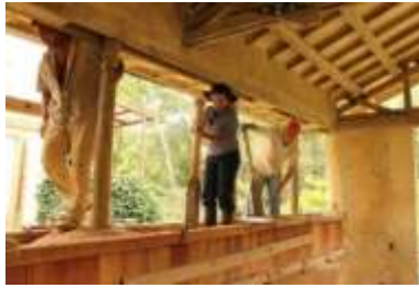
Imagen 34 Casa Mila / Construcción de Tapial
