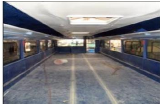
Figura 16 Colocación de pisos
