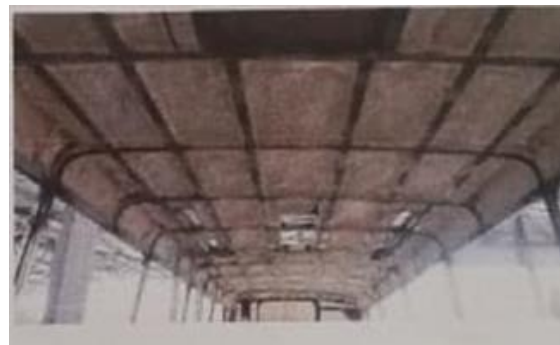
Figura 11 Forrado de techo
