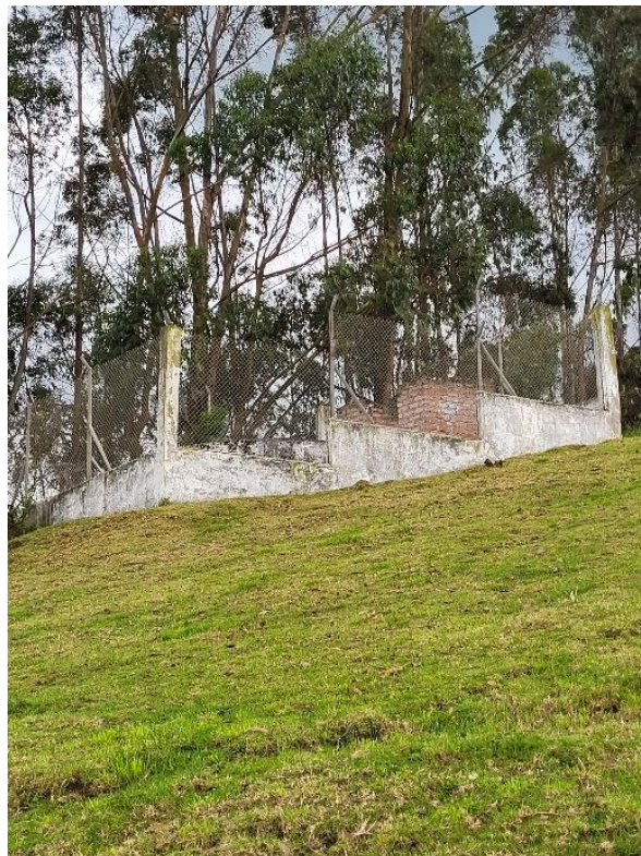
Tanque La estación, cantón Mocha
