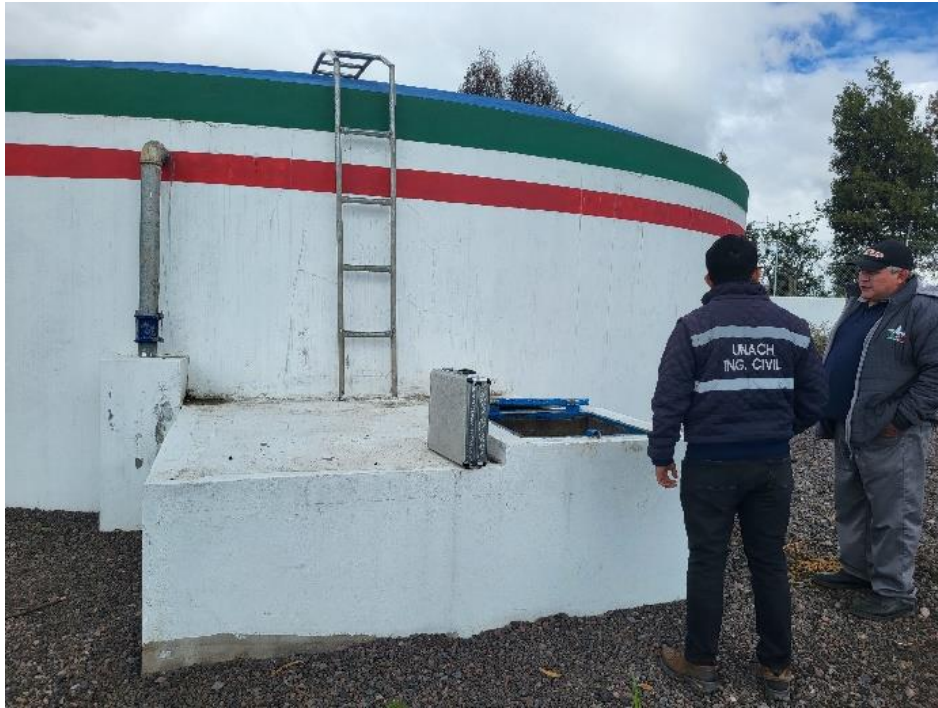
Tanque de Chilcapamba, cantón Mocha
