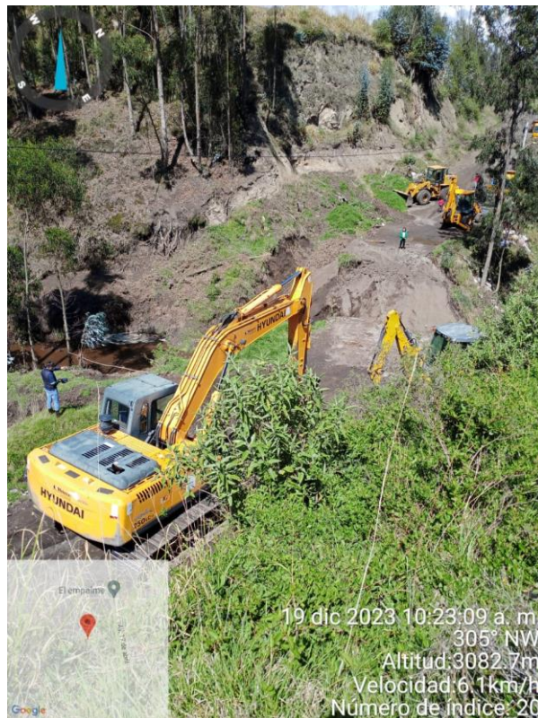
Fuga de agua potable en la ciudad de Quero
