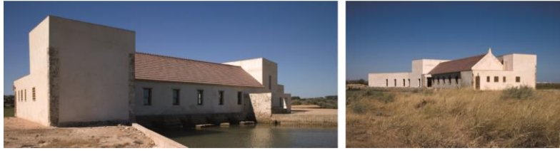
Figura 65. Estado posterior de intervención del molino mareal. Fuente: (Archdaily, 2007)
