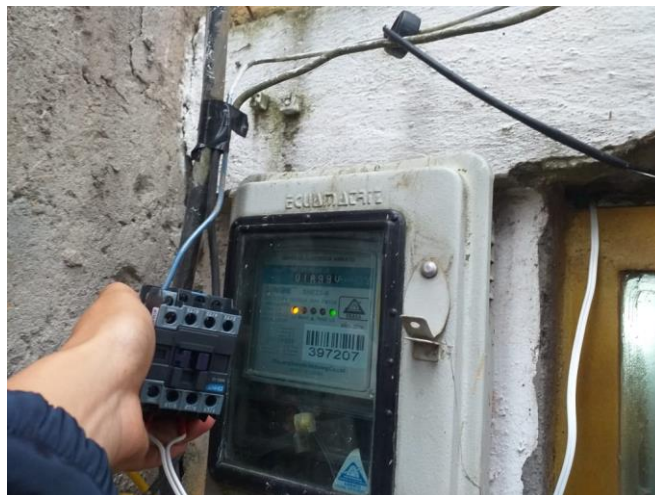
Figura 31 Instalación del contactor.
