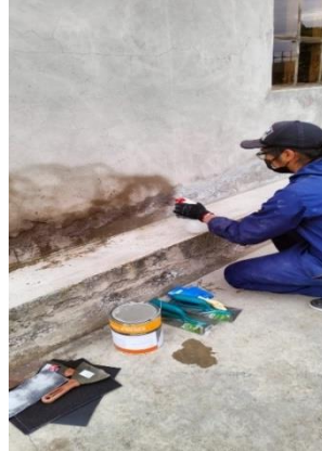
Figura 38. Proceso de curación de la pared
