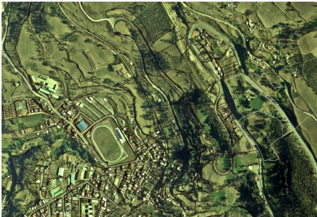
Figura 24. Estado Previo al desastre.
