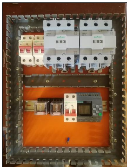
Figura 25: Instalación de dispositivos en el tablero
