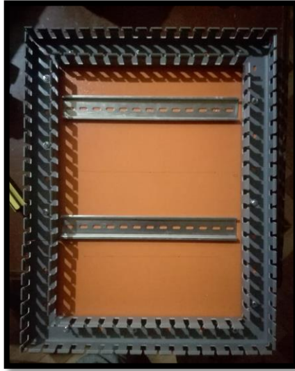
Figura 24: Colocación de Riel Din y canales
