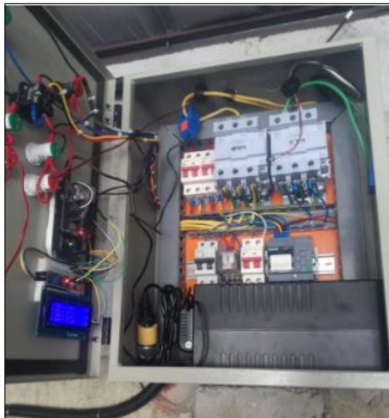
Figura 26: Conexiones físicas del tablero de transferencia
