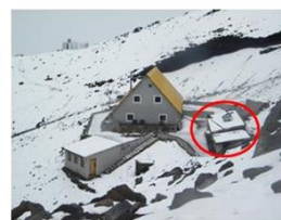
Las aguas negras son un problema para el área protegida, debido a que no se ha diseñado un lugar para su depósito, simplemente se colocó una tubería de 35 metros por debajo de los baños. Fuente: Garcés (2012).
