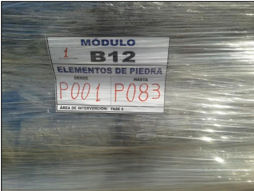
Para confinar y asegurar los elementos de piedra sobre los pallets se utilizó cinta plástica adhesiva (strech), de tal manera que los elementos a transportar estén perfectamente seguros y sujetos para evitar el riesgo de su desplazamiento fuera del pallet.
