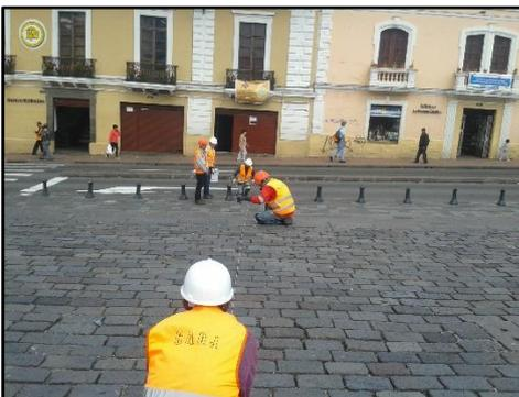
Todos los ejes señalados en los planos están marcados mediante placas de acero inoxidable en los paramentos o aceras de los cuatro costados de la plaza. Cada placa tiene la respectiva identificación del eje al cual corresponde.
