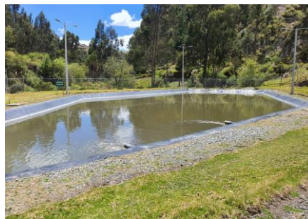
Figura 9. Laguna de Oxidación
