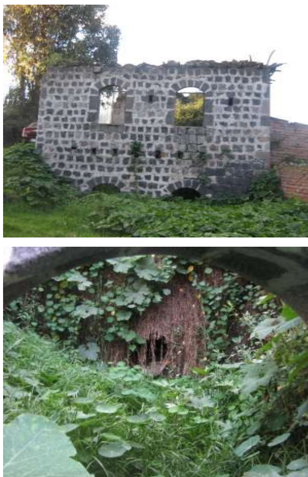
Figura 13. Planta eléctrica, ubicado en el sector San Pablo.
