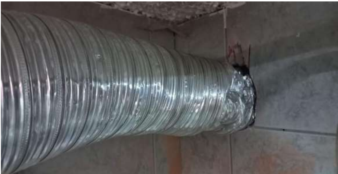
Figura 26. Instalación de conductos de aluminio para extracción de aire
